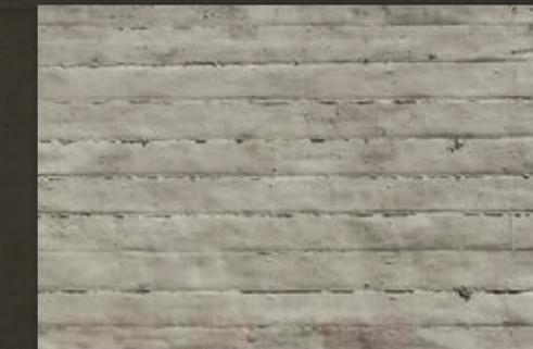
125-400 Beton encofrado / ca. 3,29x1,29 m
